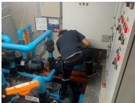
เจ้าหน้าที่ตรวจสอบใช้ระบบกรองน้ำสระว่ายน้ำ
