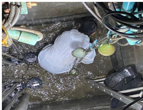
งานดูแลทำความสะอาดบ่อเกรอะ-บ่อไขมัน รูปที่ 2.1-8 การจัดการระบบบำบัดน้ำเสียของโครงการ (ต่อ)
