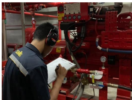
เจ้าหน้าที่ตรวจสอบใช้ระบบปั๊มสูบน้ำดับเพลิง
